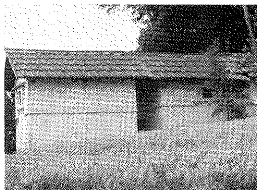
屋根が接続している石蔵
