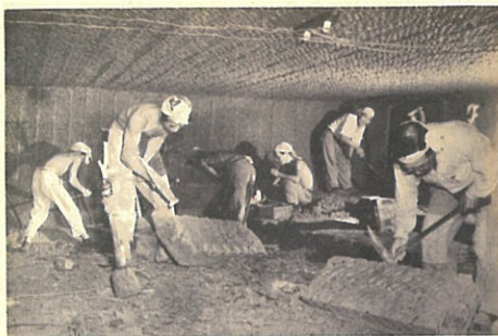
平場掘り 垣根掘りで出来た空間を 下に掘り進む
